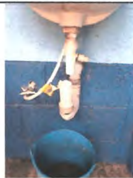
Foto 2: Sustitución de accesorios de sanitarios y accesorios de lavamanos.
