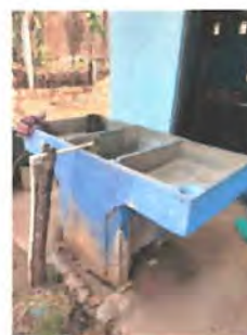
Foto 6: Sustitución pila, nivelada y con conexiones hidráulicas.
