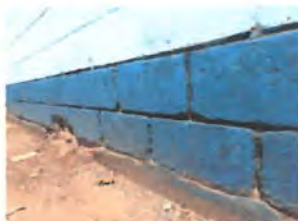
Foto 5: Reparación de repello y cernido en muro de mampostería con aplicación de acabado uniforme.
