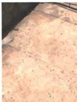
Foto 3: Reparación de losa de concreto para patios, considerando preparación de terreno, armado, nivelación y acabado rustico.
